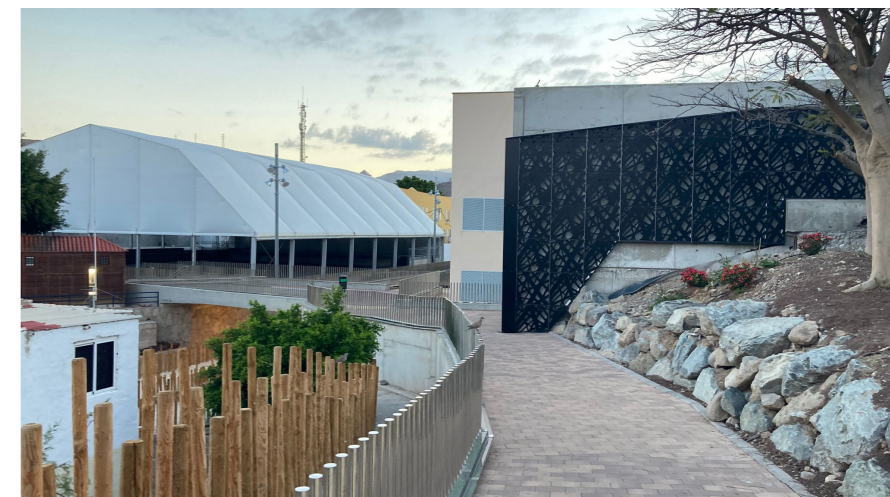
Aparcamiento subterráneo junto al barranquillo de Pino Seco y conexión peatonal. Fuente: Ayuntamiento de Mogán.
