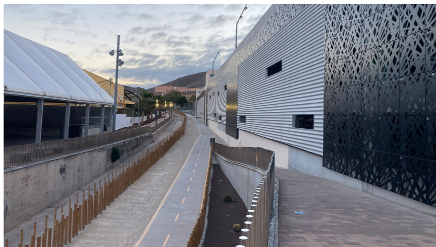
Aparcamiento subterráneo junto al barranquillo de Pino Seco, con paseo y carril bici. Fuente: Ayuntamiento de Mogán.
