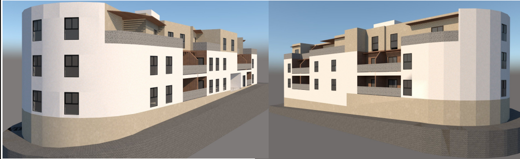
TESTIGO 01 (C1): Edificio de 23 Viviendas y 23 Trasteros. Situación: C/ Damasco – Arguineguin Año de proyecto 2023
