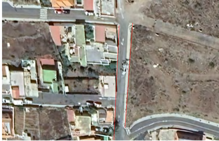
Imagen: ortofoto aérea – urbanización ejecutada
