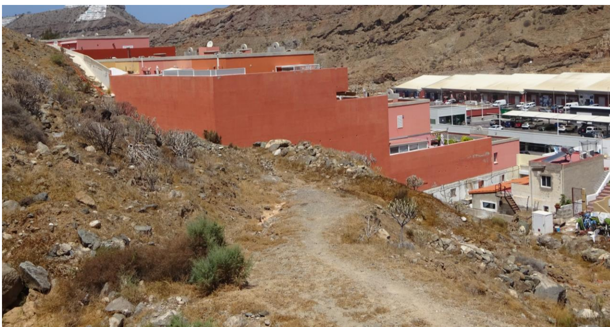
Ilustración 17. Fotografías de la Parcela A4 en el ámbito de ordenación. Fuente: aportación propia.
